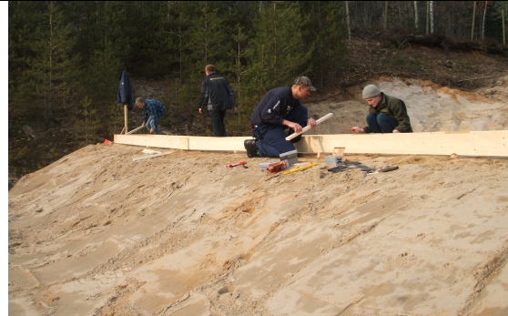
Jordvolden er på plass og forskalingen er under arbeid
